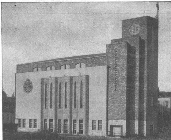
Bitumitekt-Flachdach auf einer Kapelle in T.
