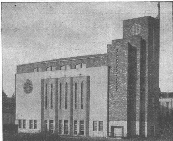
Bitumitekt-Flachdach auf einer Kapelle in T.
