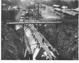
Abb. 41. Offene Betonierung am Südende des neuen Cenere-Tunnels.
