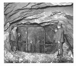
Abb. 48. Vortrieb mit 10 m2 Profilfläche im Gneis.
