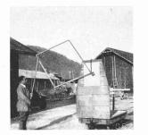
Abb. 44. Rollwagen mit Pantograph 1:20, zur Aufnahme der Stollenprofile.
