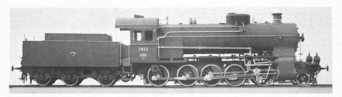
Abb. 23. C  $^{6}$ /<sub>6</sub> Vierzylinder-Verbund-Heissdampf-Güterzuglokomotive der S. L. M. Winterthur, 1913. — Dienstgewicht 128 t, Reibungsgewicht 76 t, Vmax 65 km/h. Belastungsnorm auf 26 $^{9}$ /<sub>100</sub> für Güterzüge 305 t bei 25 km/h. — (Eingehend beschrieben in "S. B. Z." 25. April 1914).
