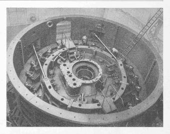
Abb. 20. Regulierung und Reguliergestänge für den Leitapparat.
