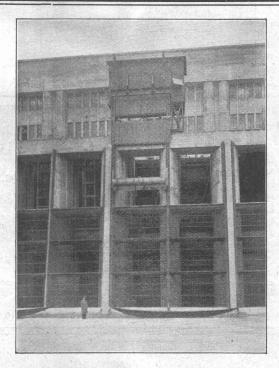
Energie Electrique du Rhin. Kraftwerk Kembs. Rechenreinigungsmaschine.
