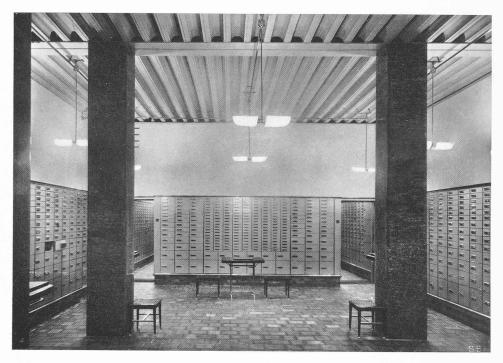
DER UMGEBAUTE SAFES-RAUM. EISENKONSTRUKTION DER DECKE SICHTBAR
