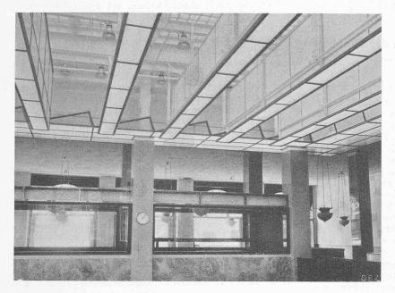
Abb. 27. Milchglas-Sheddecke der Schalterhalle, zwecks Reinigung geöffnet.
