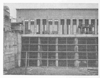
Abb. 17. Einlaufrechen vor der Turbine 1; links Trennpfeiler.
