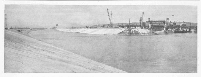
Abb. 2. Der geöffnete Einlauf des Kembser Kanals bei Km. 5 des linken Rheinufers, rechts das Stauwehr im Bau.
