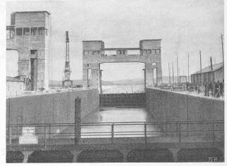
Abb. 3. Die grosse Schleusenkammer, 25 × 185 m, stromaufwärts
