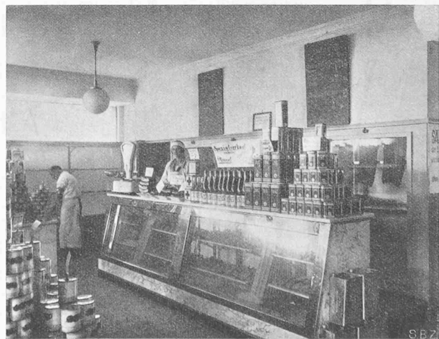
Abb. 10. Gekühlter Schaukasten für Fleischwaren.
