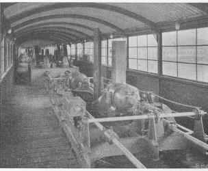
Abb. 10. Blick in die gedeckte Windwerkbrücke des Stauwehrs.
