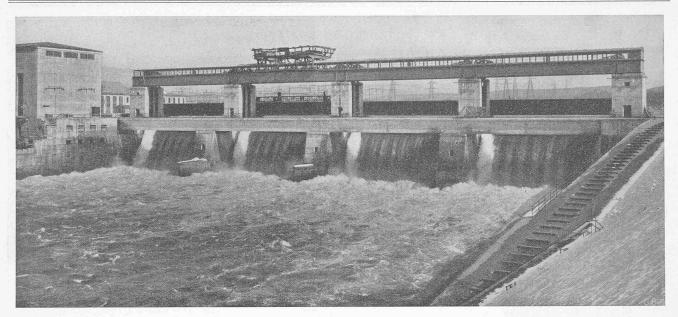
Abb. 8. Unterwasserseitige Ansicht des Stauwehrs, vom schweizerischen Ufer aus. Links das Maschinenhaus, rechts die Kahnrampe.
