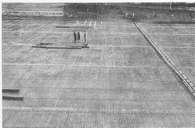
Abb. 3. Teilansicht des Rohrfeldes der Dolder-Eisbahn.
