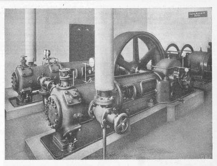
Abb. 6. Doppeltwirkende Kompressoren mit gemeinsamem Antrieb durch 180 PS Motor.
