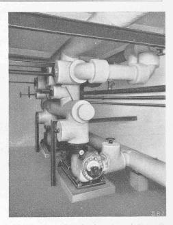
Abb. 10. Solepumpen mit Umschaltvorrichtung.
