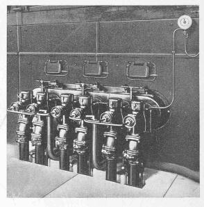
Fig. 3. Equipement de brûleurs d'une chaudière.
