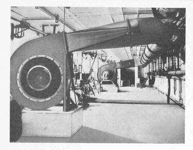
Fig. 5. Groupes moto-ventilateurs au sous-sol de la centrale.
