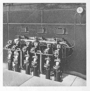
Fig. 3. Equipement de brûleurs d'une chaudière.
