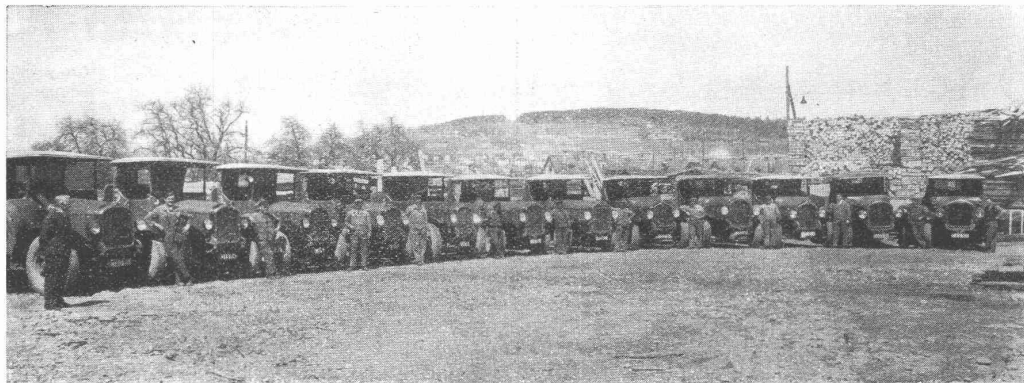
Spezialkolonne für Abbrucharbeiten, bestehend aus 12 BERNA - Dreiseitenkippern
