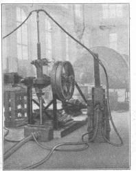
Konsolidation eines Generatorenfundamentes mit Hülfe von Kernbohrungen. Verankerungseisen und Injektionen.
