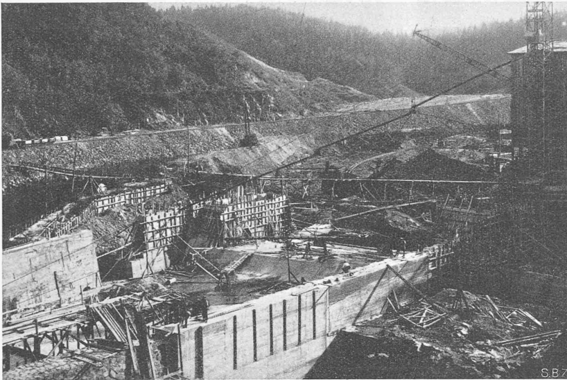
Abb. 9. Betonierung des Sturzbeckens der linken Mauerhälfte, talaufwärts gesehen. Rechts Betonwerk.
