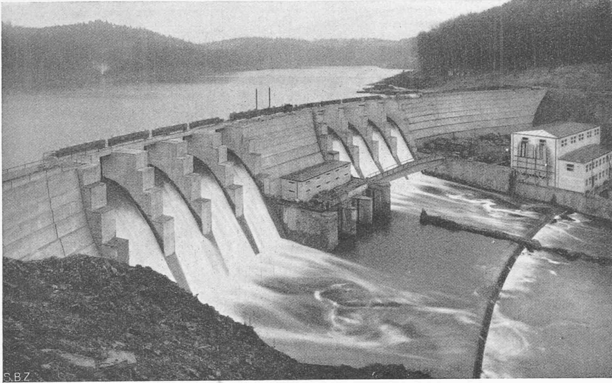
Abb. 4. Ansicht der Talsperre Kriebstein im Zschopautal (Sachsen).
