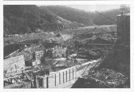
Abb. 9. Betonierung des Sturzbeckens der linken Mauerhälfte, talaufwärts gesehen. Rechts Betonwerk.
