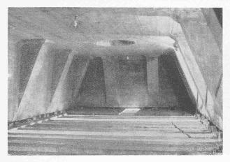
Abb. 4. Arbeitskammer eines Eisenbeton-Caisson.
