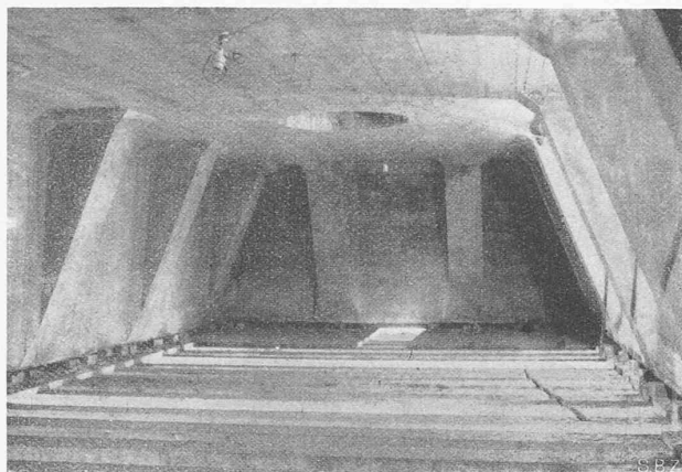
Abb. 4. Arbeitskammer eines Eisenbeton-Caisson.
