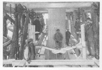
Abb. 5. Aufbau der Pfeilerschalung im Spindelgerüst.
