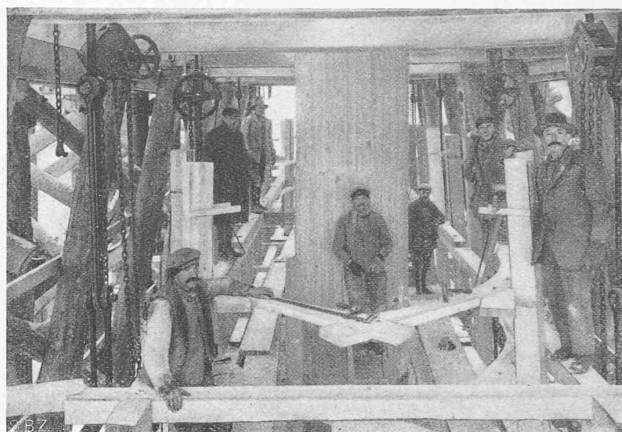
Abb. 5. Aufbau der Pfeilerschalung im Spindelgerüst.
