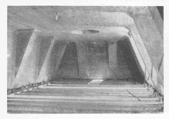
Abb. 4. Arbeitskammer eines Eisenbeton-Caisson.
