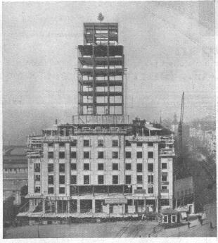
Bel-Air Metropole S. A. Lausanne Geschweisster Stahl-Skelettbau. 2000 t Stahl, 150000 m³ Volumen. Bauzeit 8 Monate.
