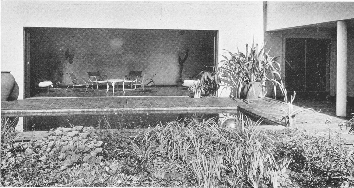
Abb. 16. DIE DURCH SEITLICH VERSCHIEBLICHE GLASWÄNDE SCHLIESSBARE GARTENHALLE, DAVOR SCHWIMMBECKEN WÄNDE EMAILFARBE (HONSALIN) IN VERSCHIEDENEN TÖNEN
