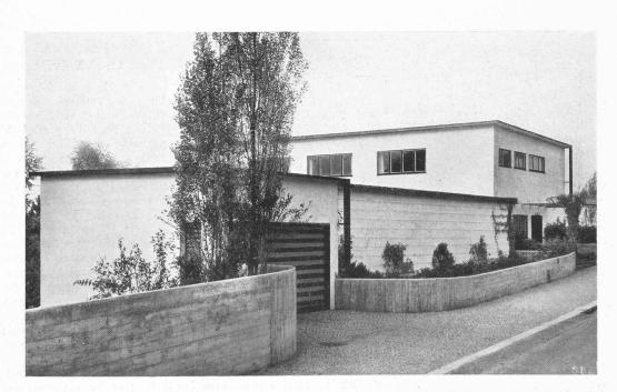
Abb. 10. GESAMTBILD DER STRASSENSEITE, LINKS VORN DIE GARAGE. FENSTERHÖLZER BLAU, WEISS UND ROT GEFASST WANDFLÄCHEN WEISS, SPENGLERARBEIT KUPFER, DACHHAUT AUFGEKLEBTES ELEKTROLYTKUPFER
