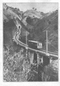
Wagen für 200 Personen und einer Fahrgeschwindigkeit von 3,13 m/sec. bei 46,7 %, max Steigung.
