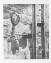
Abb. 11. Messtelle auf der Wasserseite der Staumauer Garichte.
