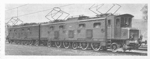
Abb. 3. Ac 8/14 Lokomotive Nr. 11851, SLM-Antrieb, Dienstgew. 246 t, Adhäsionsgew. 156 t. Dauerleistung 8300 PS bei 65 km/h.
