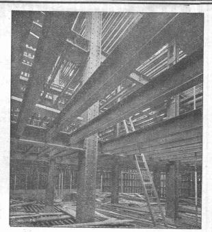
Tresorkonstruktion eines Bankgebäudes
