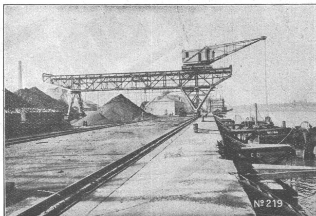
Verladeanlage im Hafen von Bilbao.
