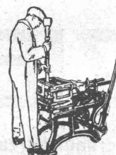
Handbedienung 300 Blöcke und Hohl- blöcke od. 1500 Steine täglich
