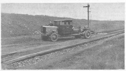
Abb. 3. Rampe für den Uebergang des Automobils von den Schienen auf die Strasse.
