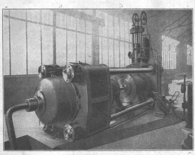
Hydraulische Metall-Stoss-Presse für 1200 Tonnen
