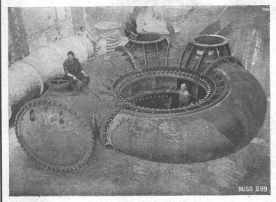
Spiraigehäuse einer Turbine, Durchmesser des Einlaufes 1900 mm, sich reduzierend auf ca. 1000 mm, Betriebsdruck 8 Atm., Prüfdruck 14 Atm. BUSSê BASEL
