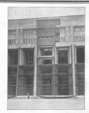
Energie Electrique du Rhin. Kraftwerk Kembs. Rechenreinigungsmaschine.
