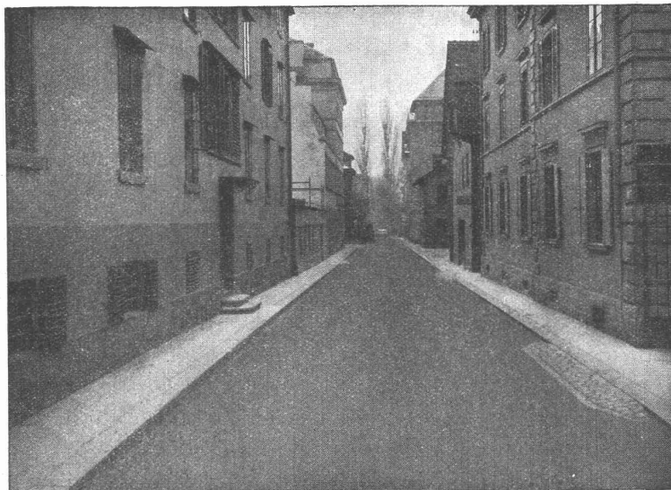
GLARNISCHSTRASSE ZÜRICH Walz-Asphalt: Topeka, 6 cm stark
