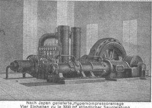
Nach Japan gelieferte<sub>«</sub>Hyperkompressoraniage Vier Einheiten zu je 3200 m³ stündlicher Saugleistung
