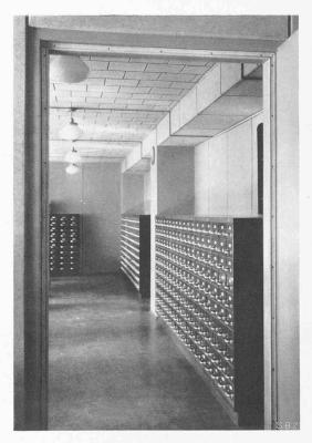
KARTENLOCH- UND ZÄHLMASCHINEN FÜR DIE VOLKSZÄHLUNG KARTOTHEK DER VOLKSZÄHLUNG IM UNTERGESCHOSS DECKEN-VERKLEIDUNG MIT AKUSTIK-CELOTEXPLATTEN, BODENBELAG EXPANKO-KORKPARKETT
