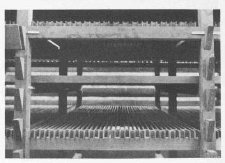
Abb. 1 und 2. Spritzteller und Latteneinbau im Gradierwerk der "Officina elettrica comunale di Lugano".
