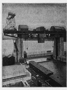
Fahrbarer Montagebockkran, Dammbalkentransportkran und Doppelwindwerke, Kraftwerk Augst-Wyhlen-
