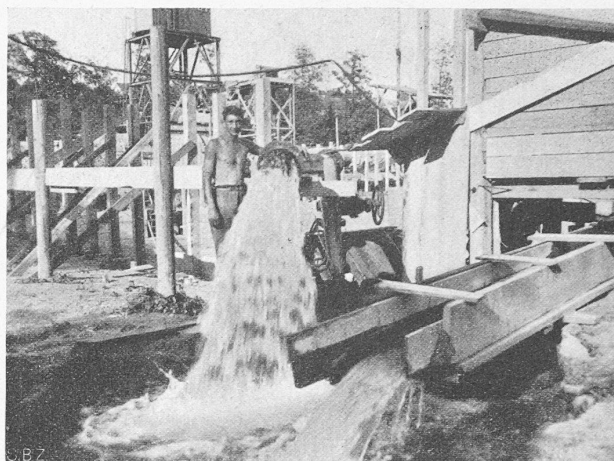
Abb. 9. Entnahme von 25000 l/min aus dem Grundwasserstrom des Limmattales bei Schlieren. (Phot. Dr. J. Hug.)
