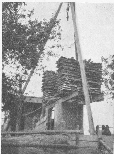
Abb. 10. Abteufen eines Rohrbrunnens von 1 m lichter Weite unter schwierigen Verhältnissen, mittels Belastung durch 25 t Eisenmasseln.
