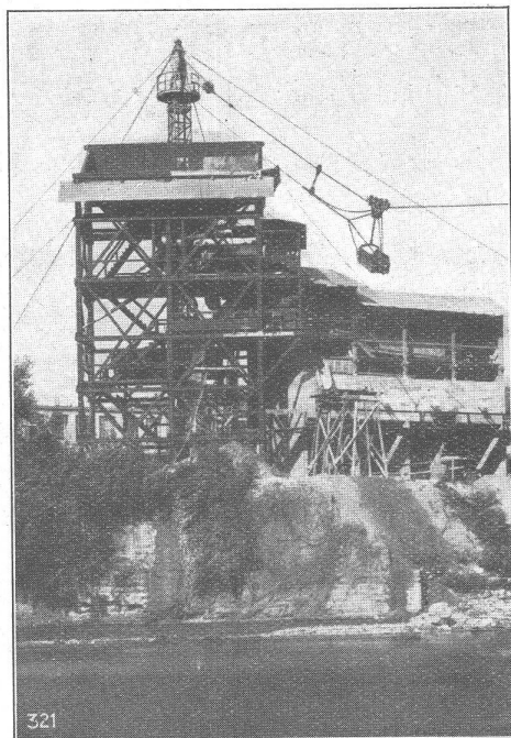
Kabelbaggeranlage an der Ärve bei Genf.
