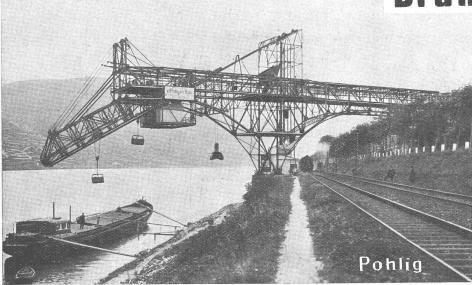
Nebenstehendes Bild veranschaulicht eine Verladeanlage in Verbindung mit Drahtseil-bahn zum Fördern von Braunstein in Rhein-schiffe und Rückfördern von Kohle.
