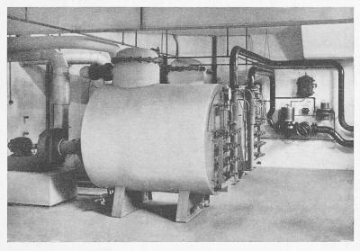
Abb. 1. Gas-Dampfkesscl der Firma Rud. Otto Meyer (ROM) in Sambury.
