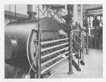
Abb. 6. Ausgeführte Anlage mit Körting-Gaskessel.
