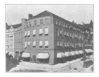
Stahlskelettbau, in den Hauptstockweiken völlig frei von inneren Eisenstützen.
