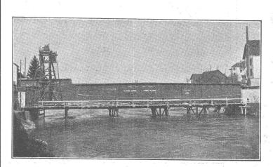
Gesamter Tiefbau, armierte Fahrbahn, Pfahlfundierung der Widerlager und Erstellen des Montagegerüstes der Reussbrücke in Mellingen
