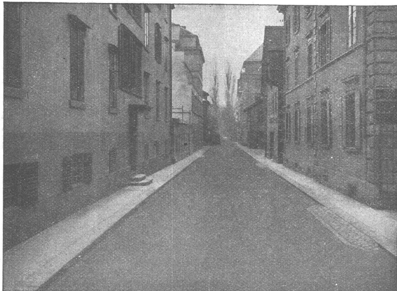
GLARNISCHSTRASSE ZÜRICH Walz-Asphalt: Topeka, 6 cm stark
