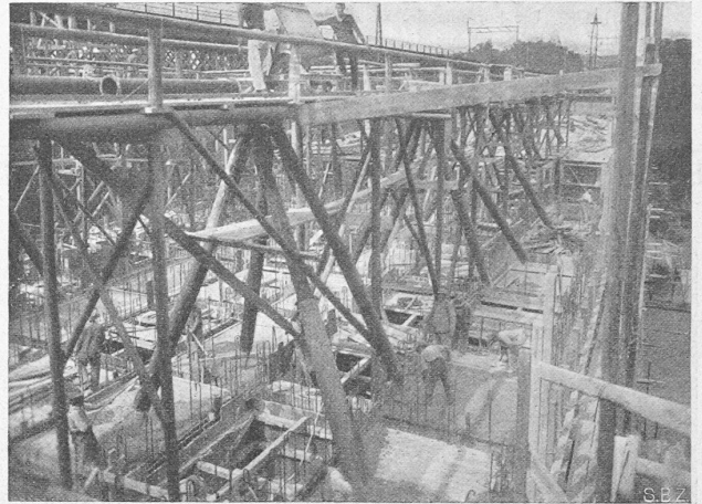
Abb. 27. Beton-Transport- und Verteilanlage.
