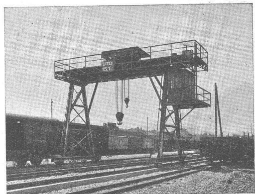
Fahrbarer Bockkran mit zwei Hubwerken
