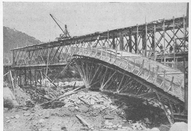
Abb. 6. Ueber dem rechtsufrigen Vorland stehen gebliebener Teil des Gerüsts.
