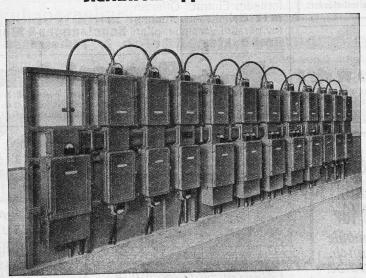
Gekapselte Niederspannungs-Verteilanlage in einer Fabrik
