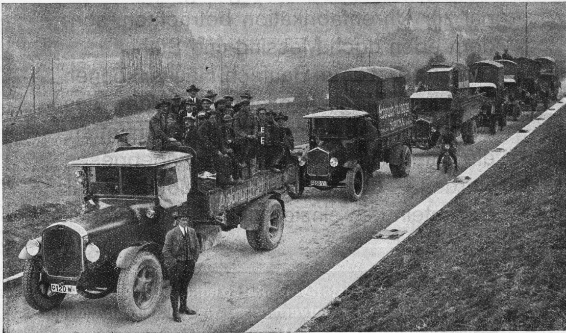
Sieben BERNAs Kipper der aus zwölf BERNAs bestehenden Kolonne für Abbrucharbeiten.
