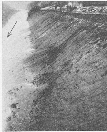
Abb. 12. Wasserseitige Dammböschung mit Zementmörtel-Austritten. (Stauspiegel abgesenkt).
