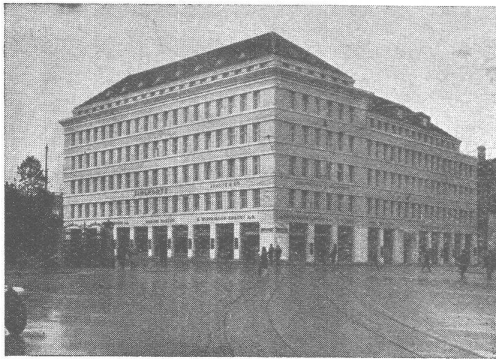
Sihlporte Zürich. Arch. Karl Knell
