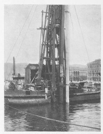
Abb. 10. Schwimmramme mit eingerammtem Triebrohr, hochgezogenem Vortriebpfahl, daneben Eisenbetonpfahl, bereit zum Einschieben ins Triebrohr.
