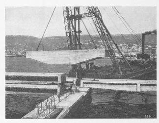
Abb. 12. Versetzen eines 35 t schweren Eisenbetonbalkens.
