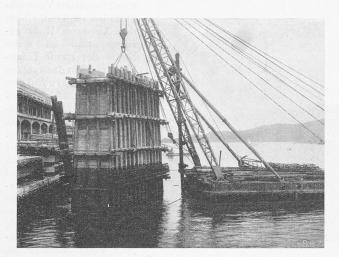
Abb. 11. Versetzen einer Pfeilerschalung.
