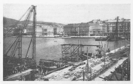
Abb. 8. Baustelle mit Schwimmkran, Schwimmramme und Betonierungskran.
