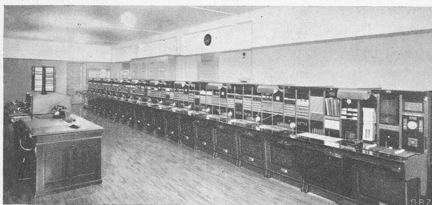
Abb. 13. Telefon-Fern-Zentrale im II. Stock.
