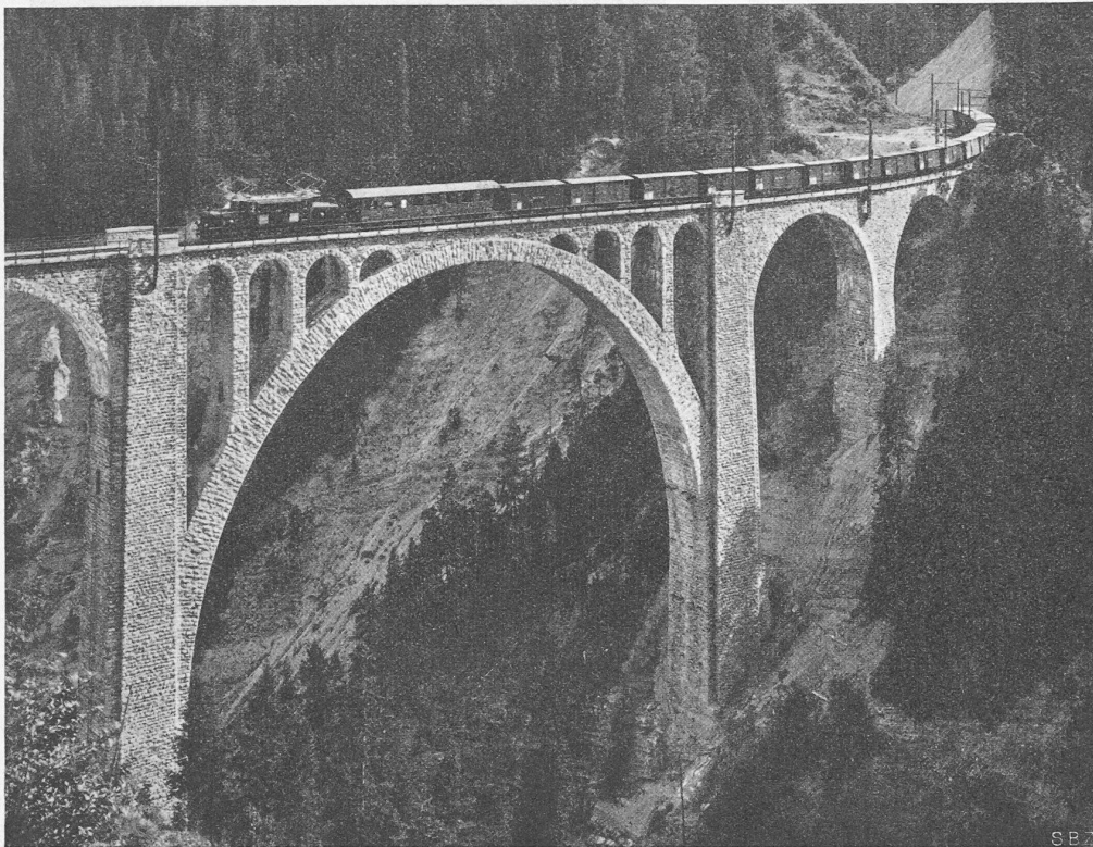
Abb. 1. Der Wiesener Viadukt der Rhät. Bahn über das Landwasser. Ansicht aus Norden.
