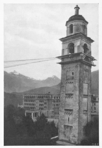
Abb. 6. Verankerung während der Fundament-Unterfangung.
