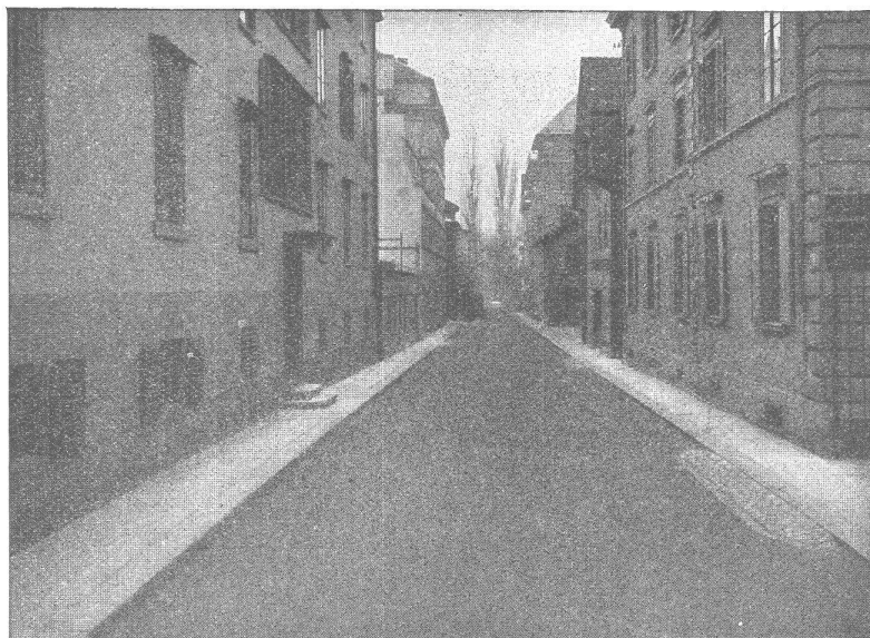
GLARNISCHSTRASSE ZÜRICH Walz-Asphalt: Topeka, 6 cm stark
